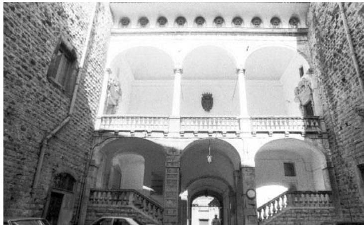
La Ripartizione tecnica del Comune di Acquaviva (nella foto a sinistra), con un'ordinanza, ha intimato l'interruzione dei lavori di costruzione di un ufficio. Bisogna valutare eventuali irregolarità urbanistiche
