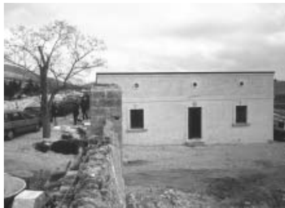
Fig. 1 - Esterno dei locali della Masseria Ragone in fase di ristrutturazione.
