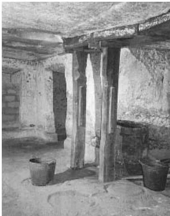
Fig. 7 - Frantoio Paolotti II - Resti di torchi con tini in lamiera zincata.
