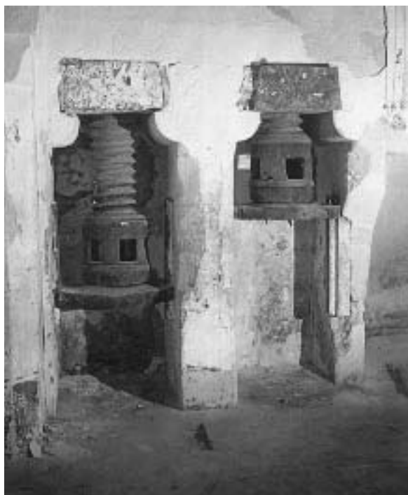
Fig. 8 - Frantoio Paolotti II - Torchietti di seconda spermitura.
