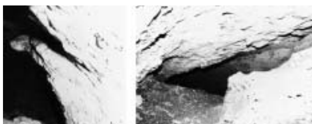
Fig. 20 - La polvere di grotta che imbianca le superfici della roccia calcarea e che si insinua nei giunti della volta e dalle pareti fessurate facilita il distacco di scaglie, lastre e blocchi in seguito al processo di alterazione provocato dall'interazione tra l'umidità di condensa e il supporto lapideo.
